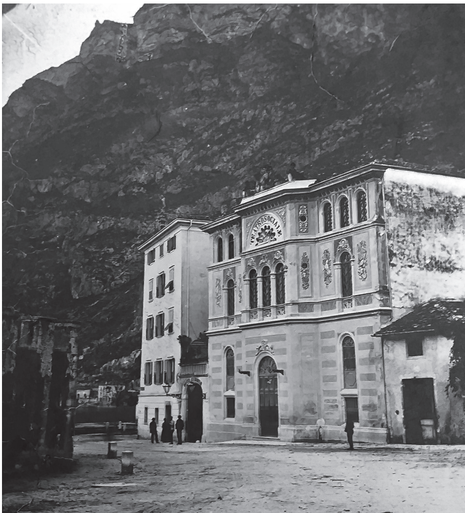
Fig. 1. Facciata del Teatro Sociale di Riva, 1878; ASCR
