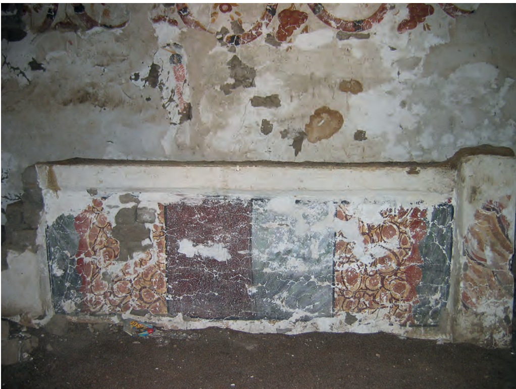
Abb. 22: Erdgeschoss, 2. Raum, Nordwand; 2005
