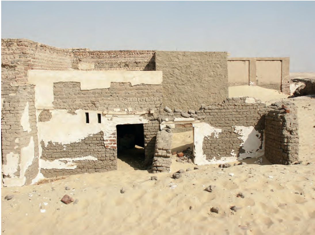
Abb. 1: Ansicht der Südfassade mit Vorhalle (GB 5.2.3–5.2.4) vor Beginn der Arbeiten im Jahr 2006
