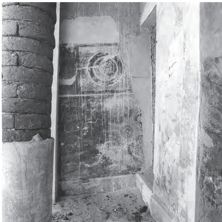
Abb. 41: Südwand der Vorhalle GB 7.2.1; 1987
