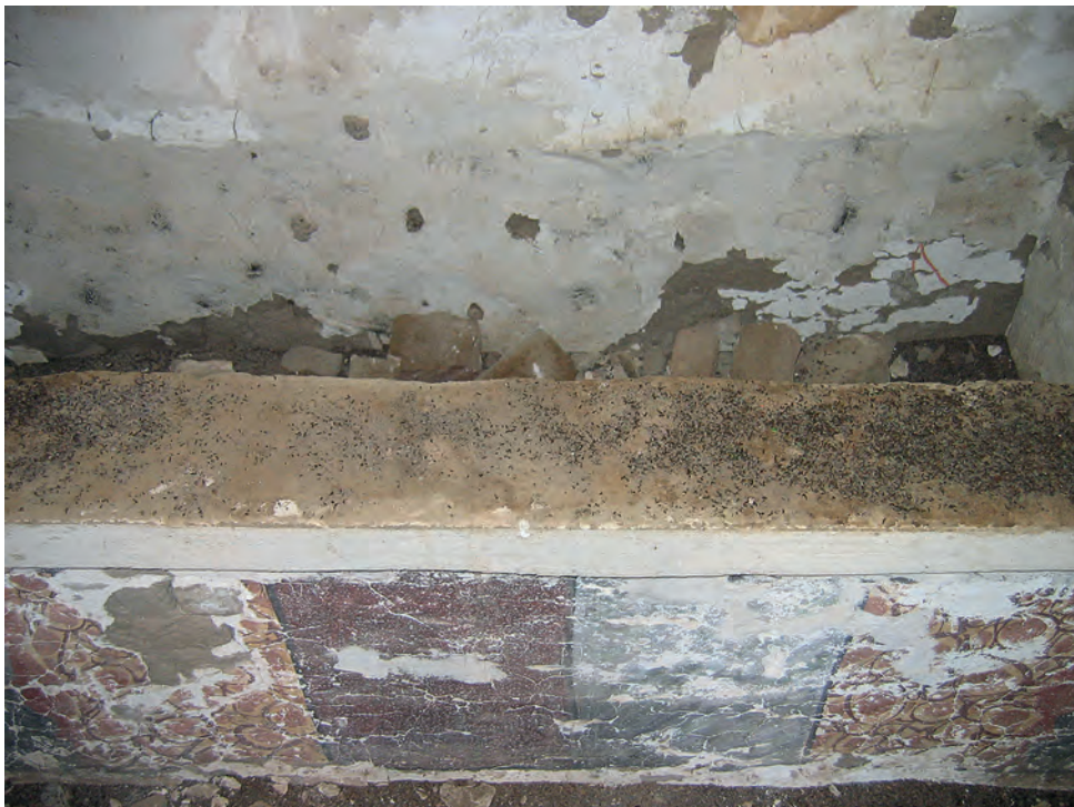
Abb. 24: Erdgeschoss, 2. Raum, Detail Nordwand; 2005
