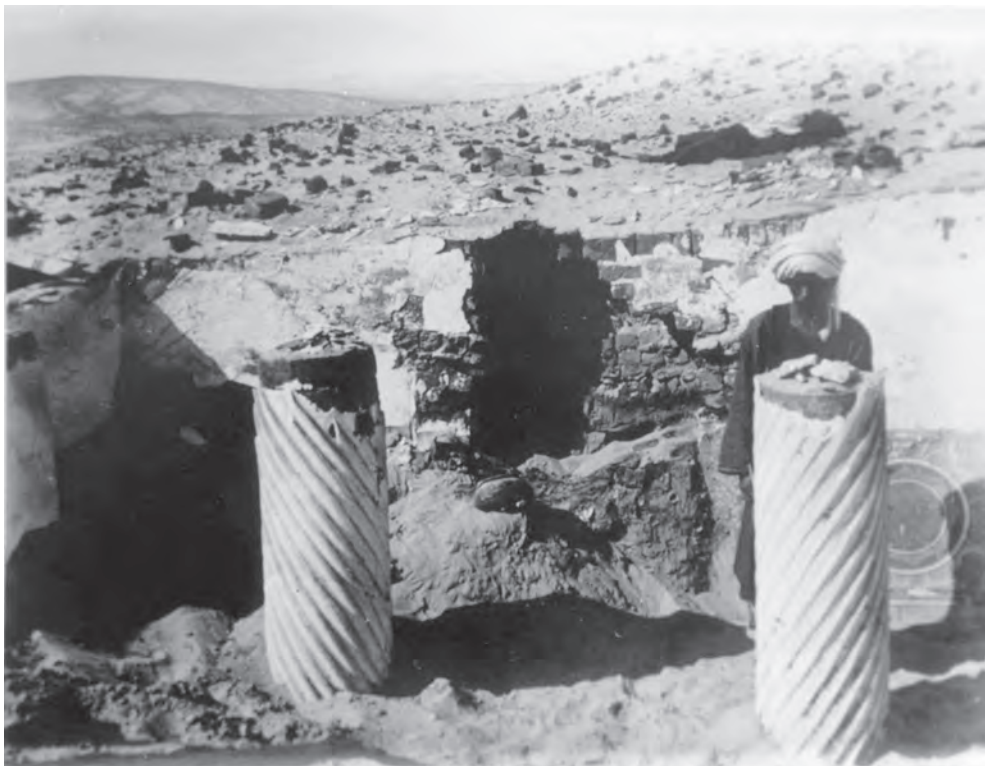
Abb. 4 a: Ansicht der Vorhalle GB 6.2.1 während der Freilegung unter der Leitung von Sami Gabra; 1934 (?)
