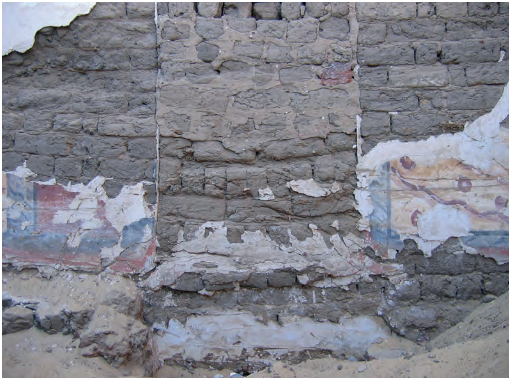
Abb. 23: Raum GB 5.2.1, Westwand mit der sekundären Vermauerung des Durchgangs in Raum GB 5.2.2; 2006
