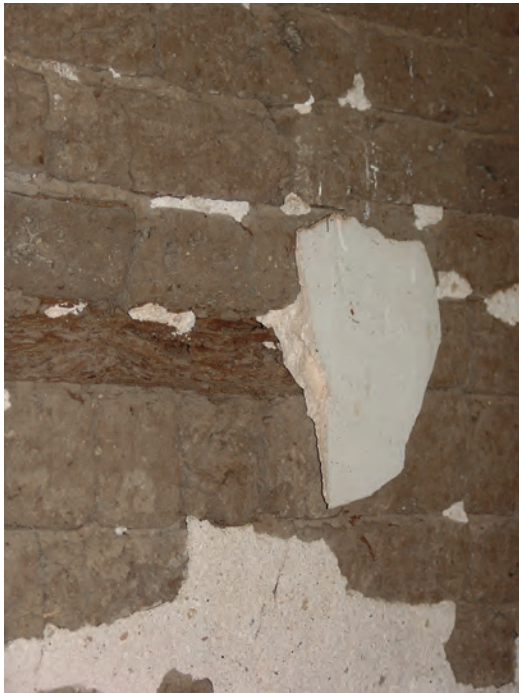
Abb. 27: Raum GB 7.2.3, Detail der Holzbewehrung in der Nordwand; 2006
