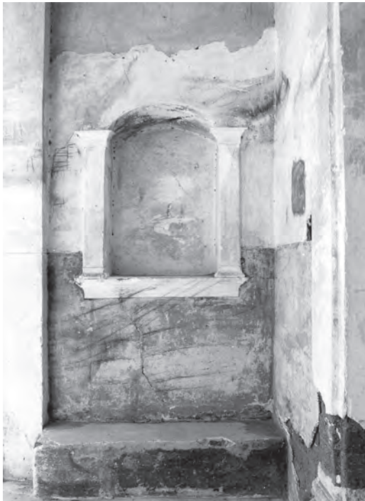
Abb. 3: Vorhalle, Nische in Westwand; 1987
