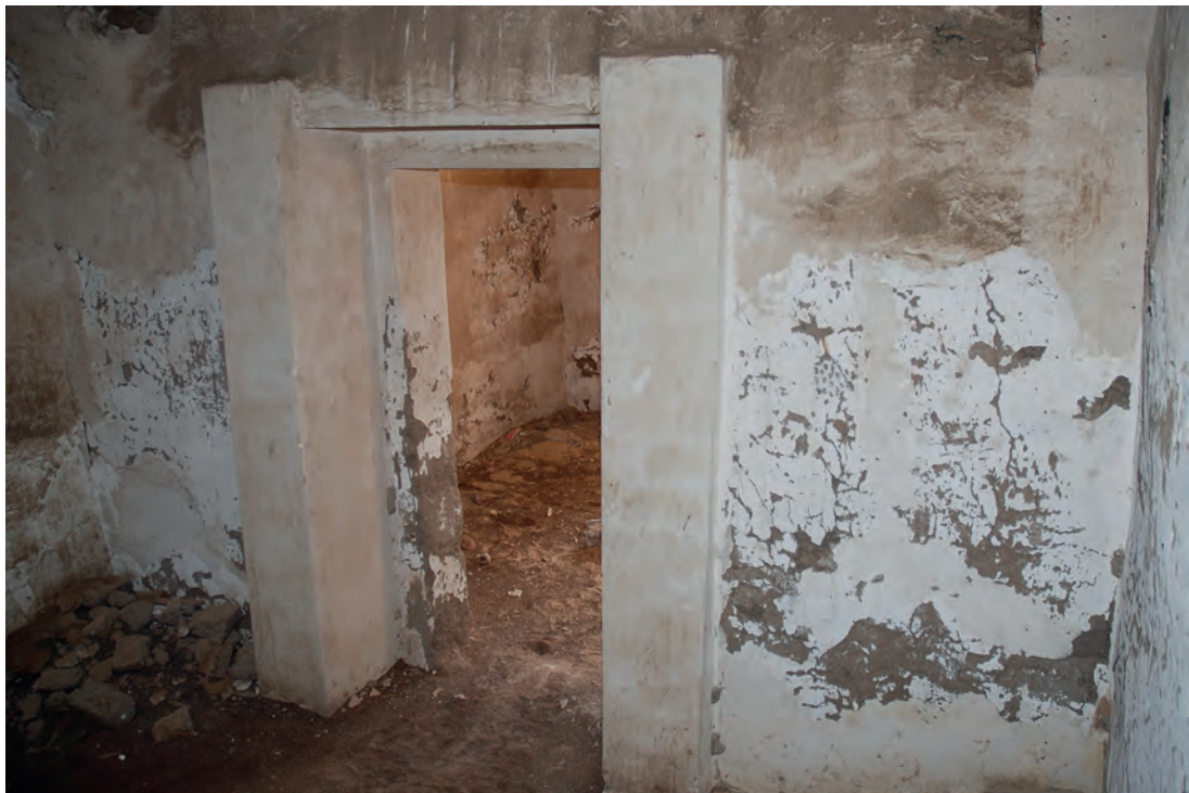
Abb. 12: Erdgeschoss, 2. Raum, Südwand von Westen; 2008
