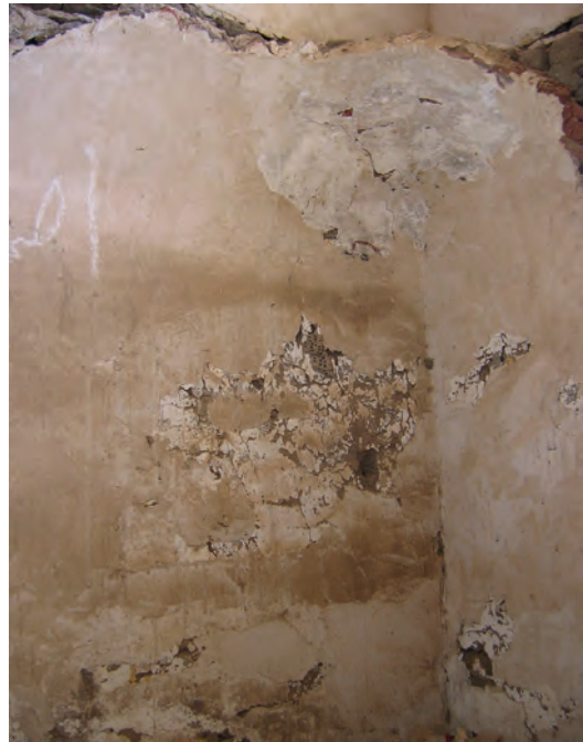
Abb. 11: Erdgeschoss, 1. Raum, Südostecke; 2005
