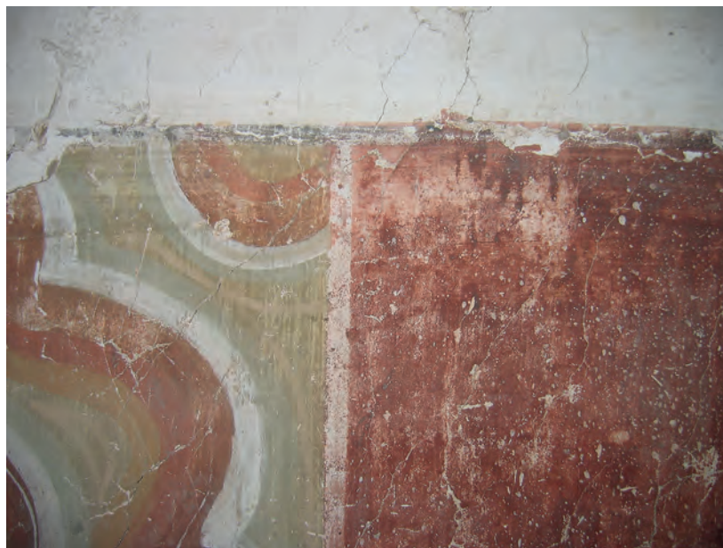
Abb. 8: Vorraum, Nordwand, Detail; 2007
