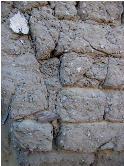
Abb. 16: GB 5, Straßentreppe aus ungebrannten Ziegeln. Hoher, südlicher Substruktionsbogen mit Keramikscherben in den Stoßfugen; 2006
