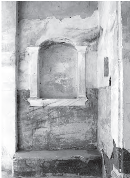
Abb. 3: Vorhalle, Nische in Westwand; 1987
