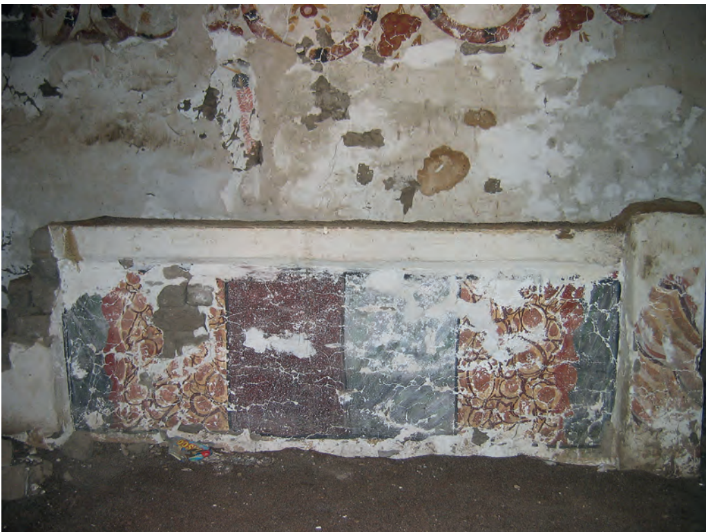
Abb. 22: Erdgeschoss, 2. Raum, Nordwand; 2005
