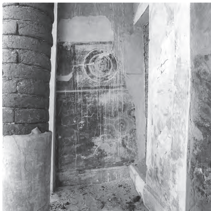
Abb. 41: Südwand der Vorhalle GB 7.2.1; 1987
