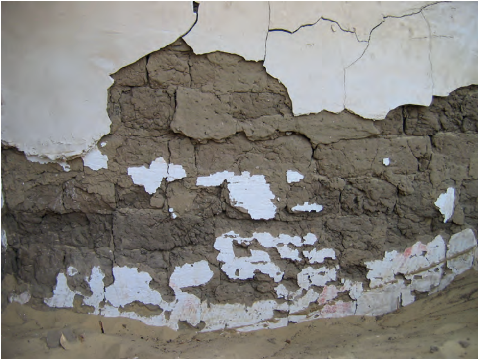
Abb. 13: Detail der Nordfassade des Untergeschosses mit Resten von Bemalung; 2007
