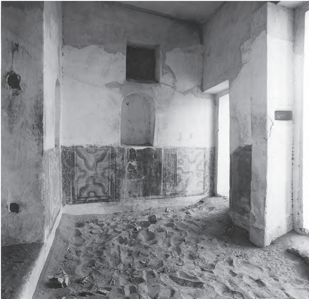
Abb. 18: Nordseite von Raum GB 6.2.2; 1987
