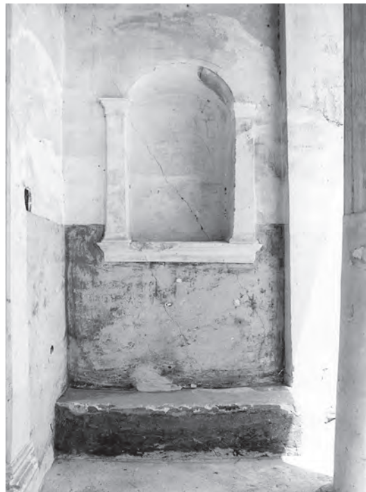
Abb. 4: Vorhalle, Nische in Ostwand; 1987
