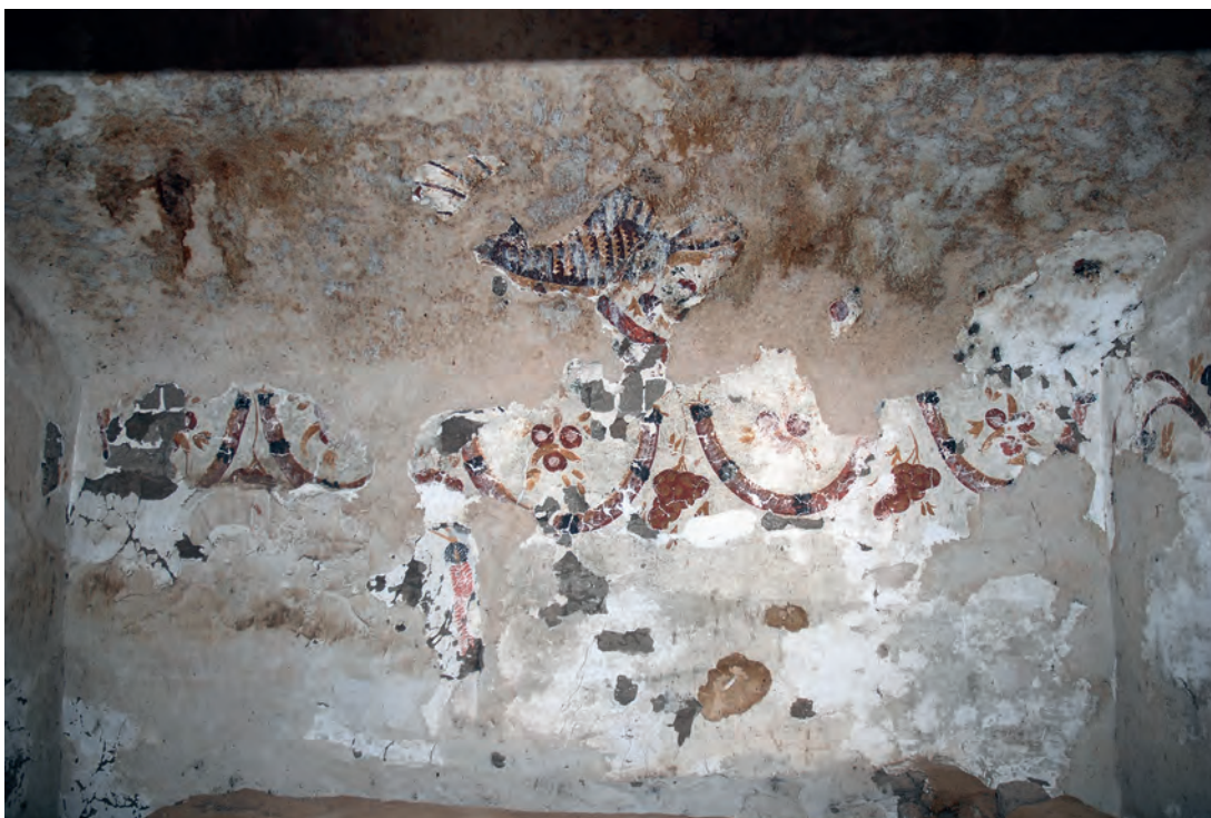
Abb. 5: Erdgeschoss, 2. Raum, Nordwand; 2008
