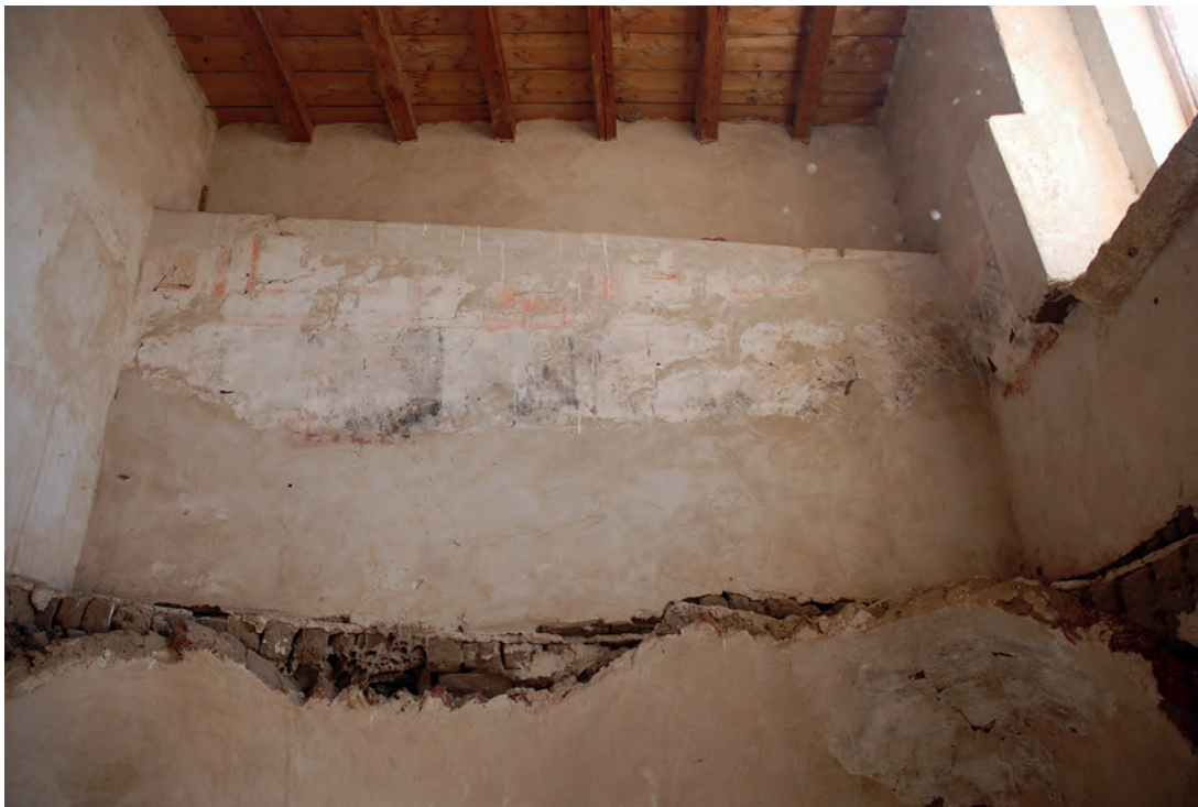
Abb. 4: Obergeschoss, 1. Raum, Ostwand; 2008
