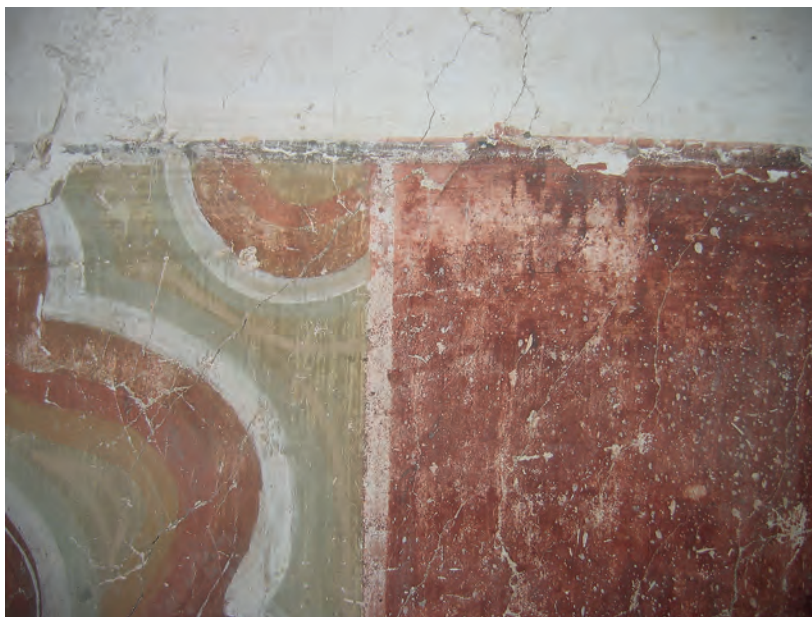
Abb. 8: Vorraum, Nordwand, Detail; 2007
