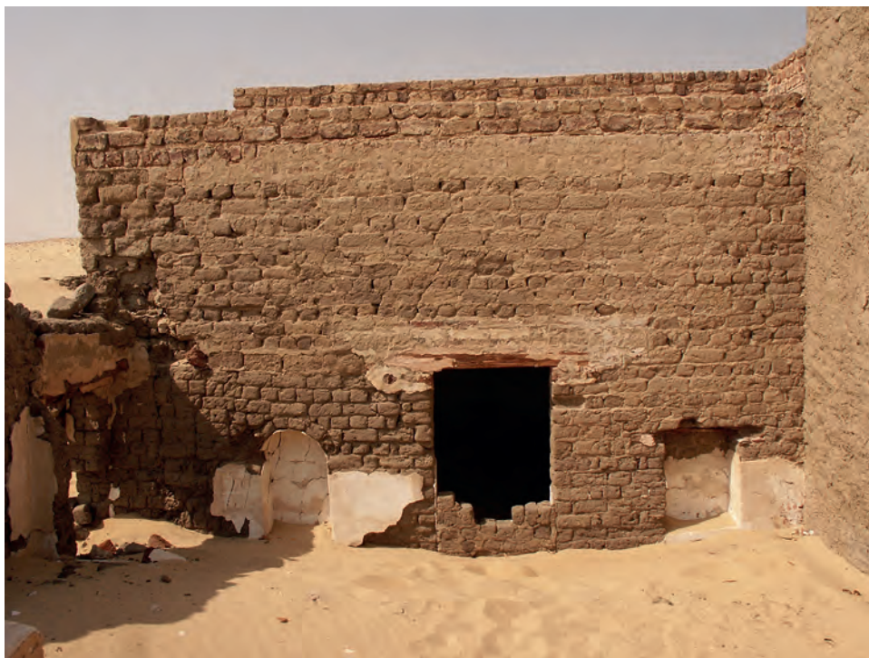
Abb. 19: Raum GB 5.2.1, Westwand mit zwei Nischen und zugesetzter Tür, Ansicht von Osten; 2006
