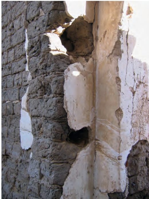
Abb. 11: GB 5.2.1, Haupteingangstür von der Rauminnenseite, östliche Laibung mit zwei unregelmäßigen Riegelöchern; 2006
