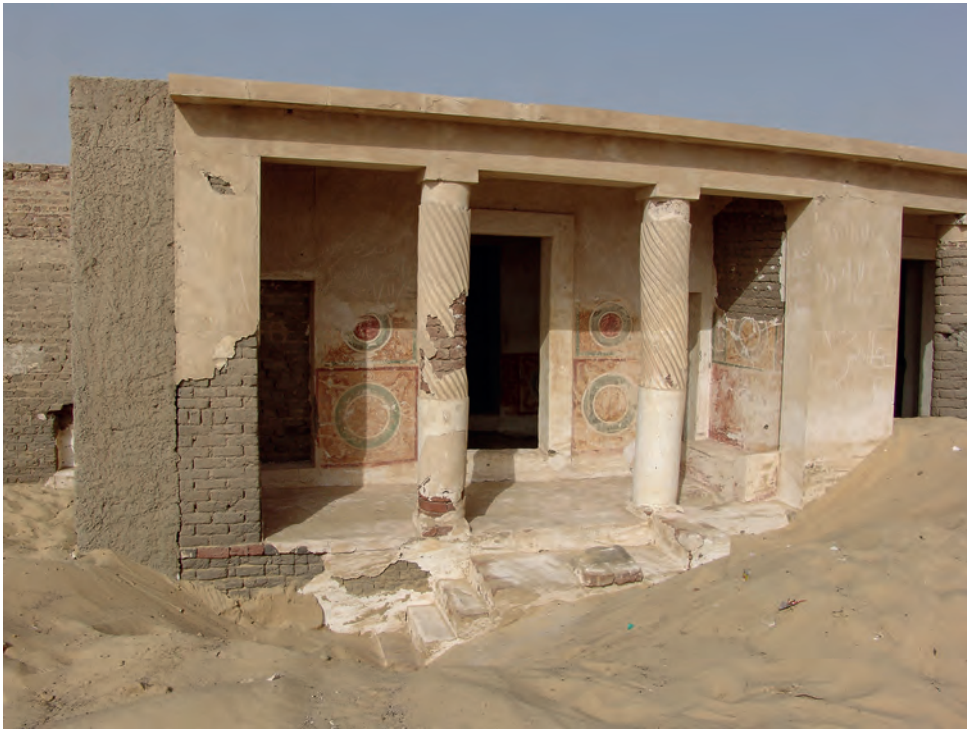
Abb. 7 a: Vorhalle GB 6.2.1; 2007
