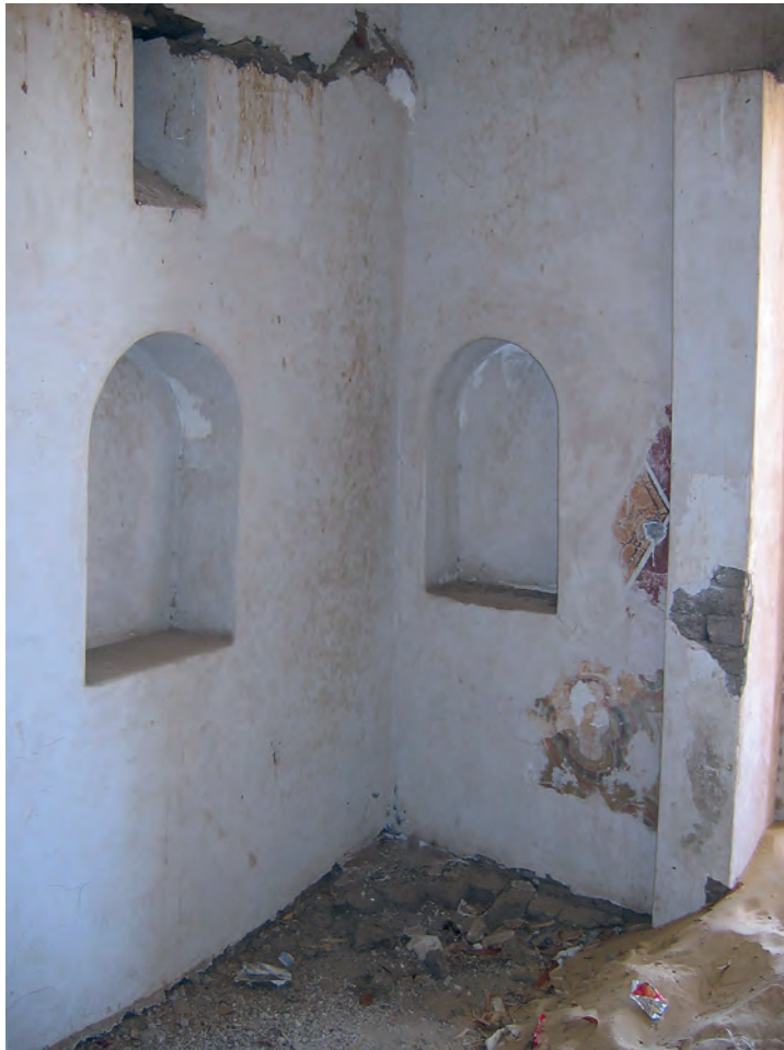
Abb. 20: Blick in die Nordostecke von Raum GB 7.2.2; 2005
