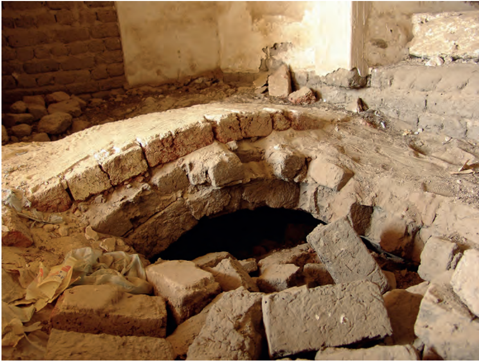
Abb. 8: Gewölbeausbruch im Fußboden in Raum GB 6.2.3; 2006
