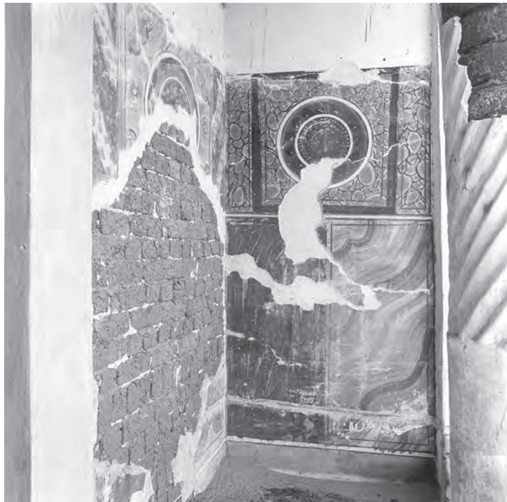
Abb. 40: Nordwand der Vorhalle GB 7.2.1; 1987
