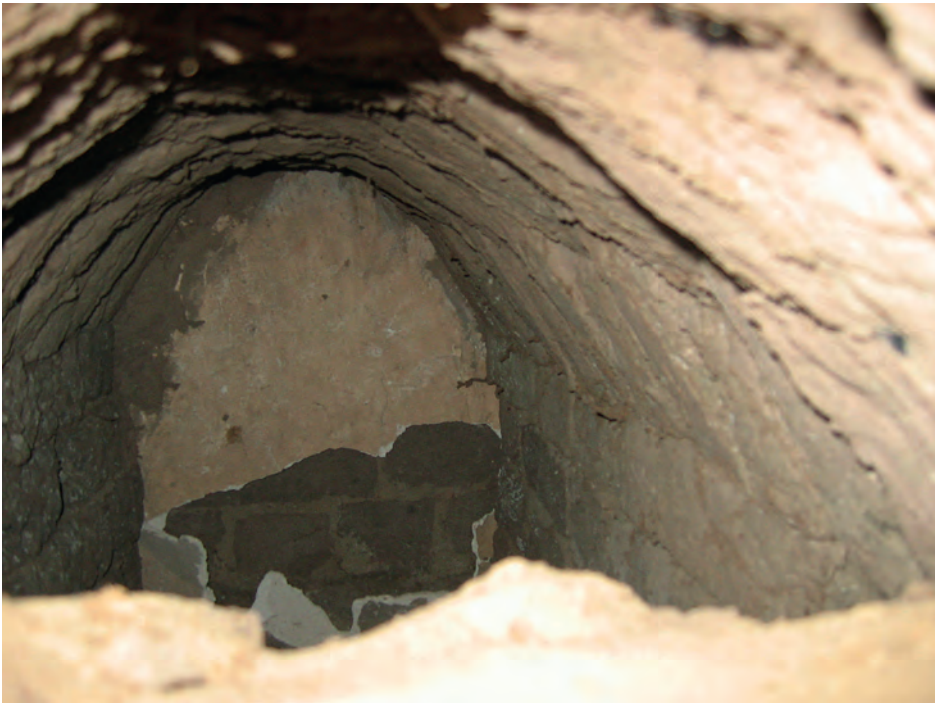
Abb. 9: Vorhalle (GB 5.2.3), Blick in einen Substruktionsbogen; 2007
