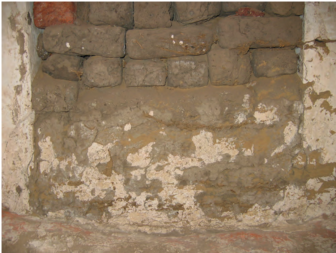
Abb. 26: Raum GB 5.2.2, Ostwand. In der Antike sekundär zugesetzter Durchgang zu Raum GB 5.2.1. Die oberen drei Lagen aus wiederverwendeten Ziegeln wurden später hinzugefügt (Rekonstruktion), Blick nach Osten; 2006
