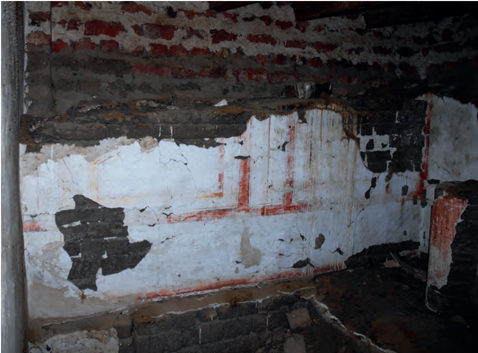
Abb. 18: Obergeschoss, 2. Raum, Westwand; 2008
