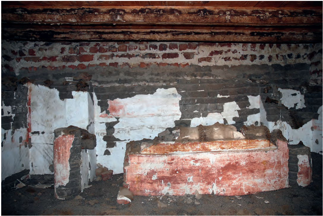
Abb. 19: Obergeschoss, 2. Raum, Nordwand; 2008
