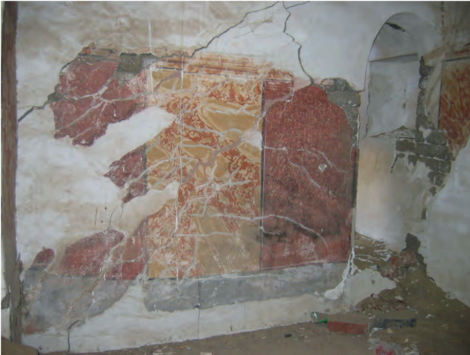
Abb. 10: Obergeschoss, 1. Raum, Ostwand; 2006
