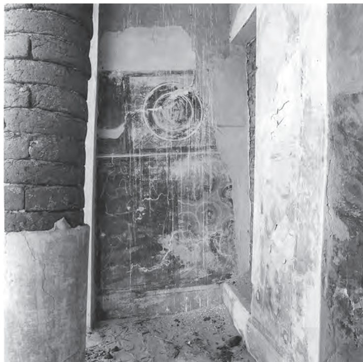
Abb. 41: Südwand der Vorhalle GB 7.2.1; 1987
