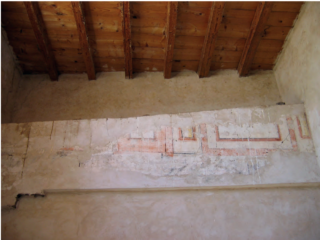
Abb. 17: Obergeschoss, 1. Raum, Westwand; 2005
