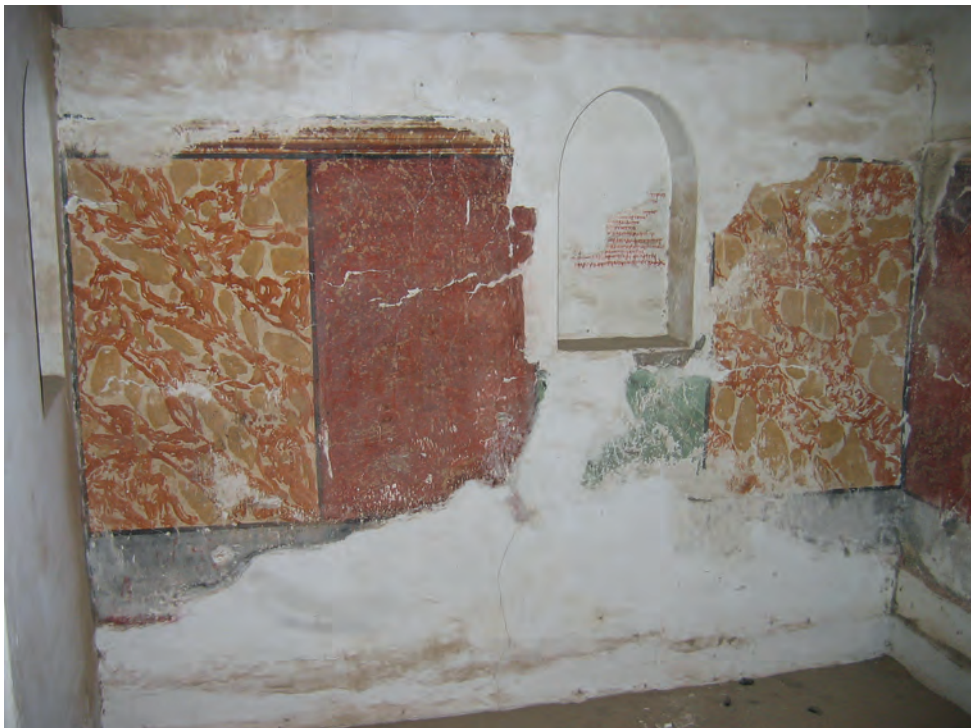
Abb. 9: Obergeschoss, 1. Raum, Westwand; 2006
