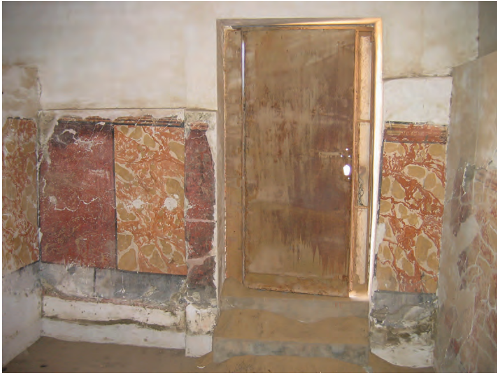
Abb. 8: Obergeschoss, 1. Raum, Nordwand; 2006
