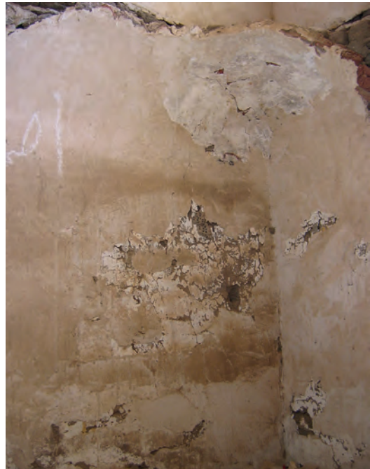
Abb. 11: Erdgeschoss, 1. Raum, Südostecke; 2005
