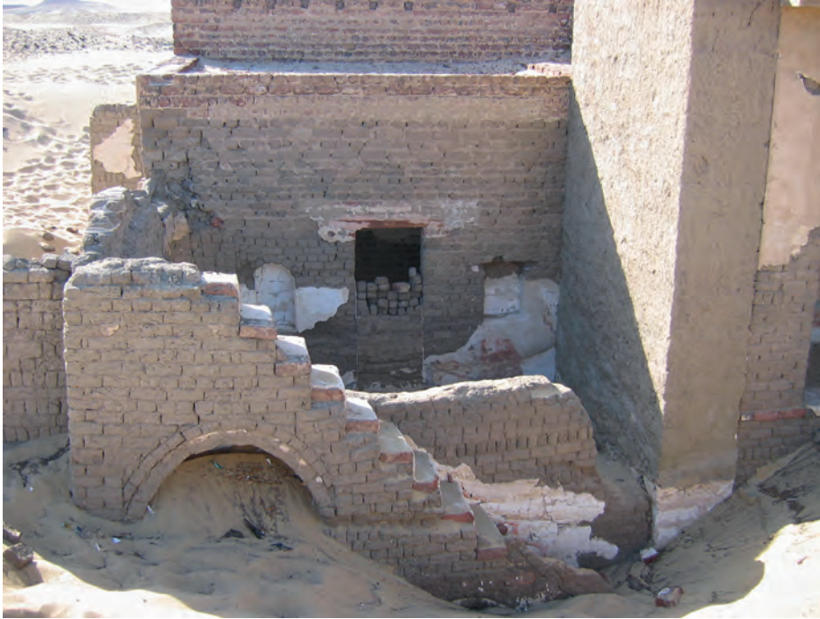
Abb. 12: GB 5, Ostansicht. Straßentreppe zum oberen Geschoss und dahinter die Ostfassade mit Resten des ursprünglichen Fassadenputzes. Rückseitig Raum GB 5.2.1 mit der Westwand und zentraler, zugesetzter Tür zu Raum GB 5.2.2, zwei Nischen und Wandmalereiresten; 2006
