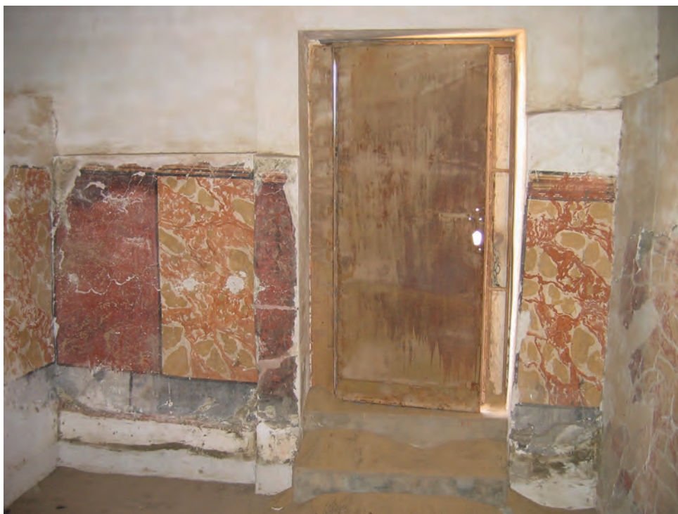
Abb. 8: Obergeschoss, 1. Raum, Nordwand; 2006
