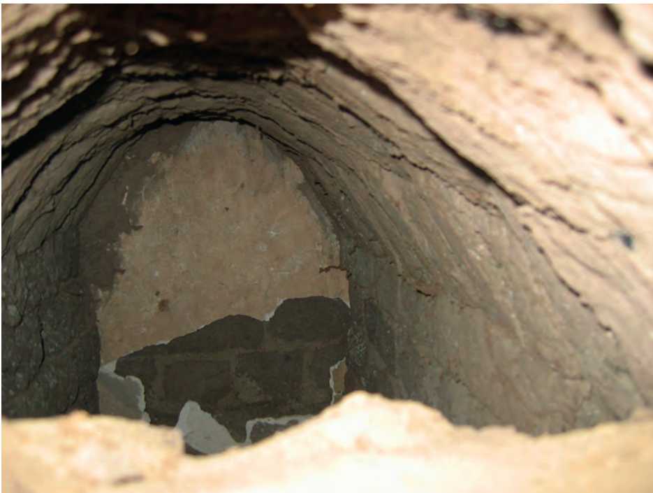
Abb. 9: Vorhalle (GB 5.2.3), Blick in einen Substruktionsbogen; 2007
