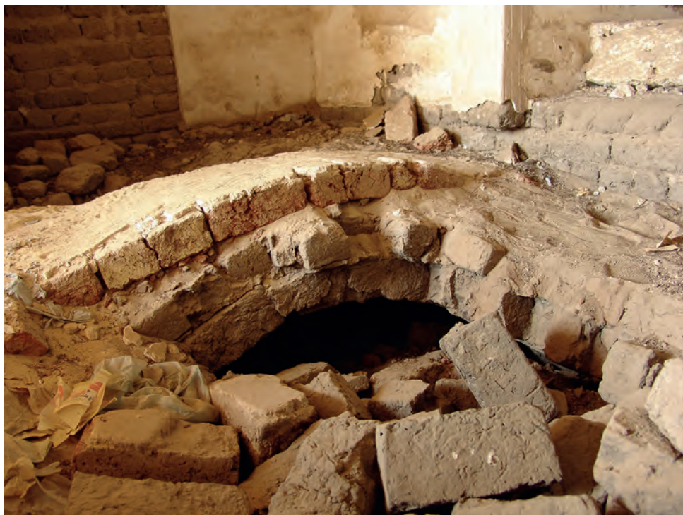
Abb. 8: Gewölbeausbruch im Fußboden in Raum GB 6.2.3; 2006
