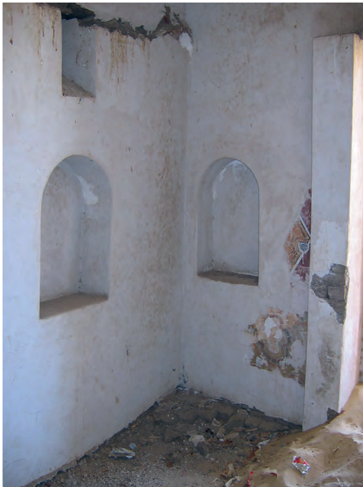
Abb. 20: Blick in die Nordostecke von Raum GB 7.2.2; 2005
