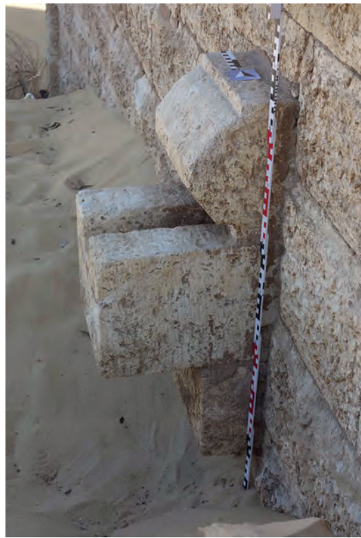
Abb. 4 a: Wasserspeier an GB 14, Ansicht von Süden; 2021
