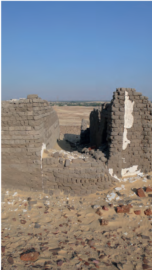
Abb. 36: Spätere Nilschlammziegelmauer in der Gasse zwischen GB 201 und GB 203, Blick nach Osten; 2008
