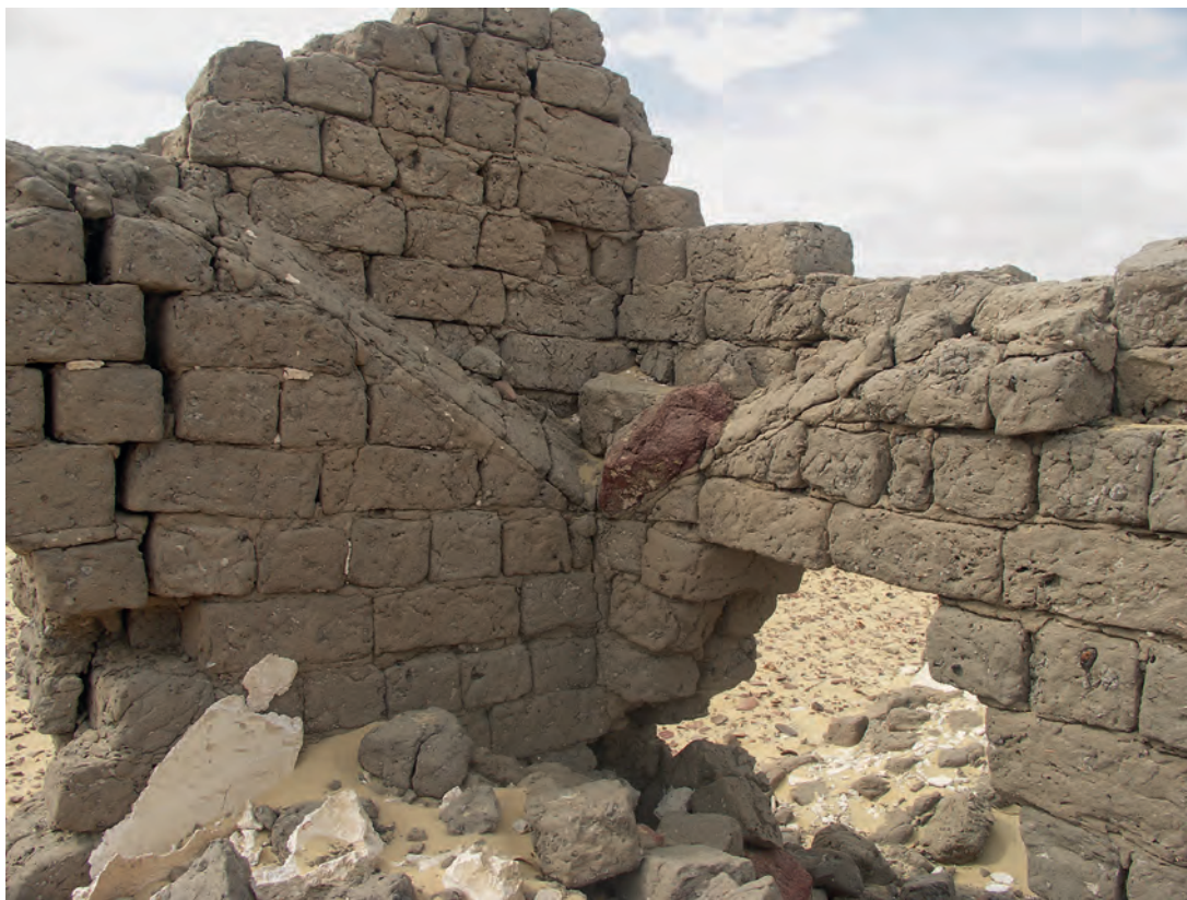
Abb. 19: GB 201.1.1, Reste der Hängekuppel aus gebrannten Ziegeln in der Nordwestecke; 2010
