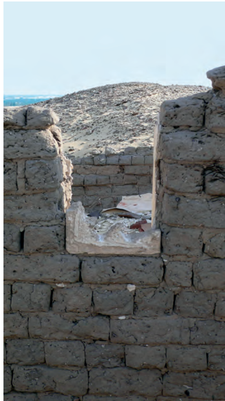
Abb. 16: GB 201.1.2, Außenansicht des Fensters von Norden mit unvollständig erhaltenem Fenstergitter aus Kalkstein; 2008
