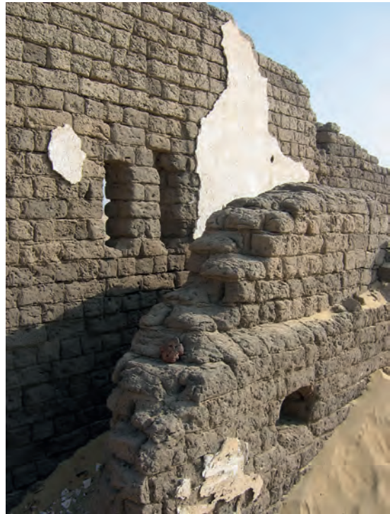
Abb. 32: GB 204.2.4, Rundbogennische mit Fensteröffnungen, Außenansicht von Süden; 2010
