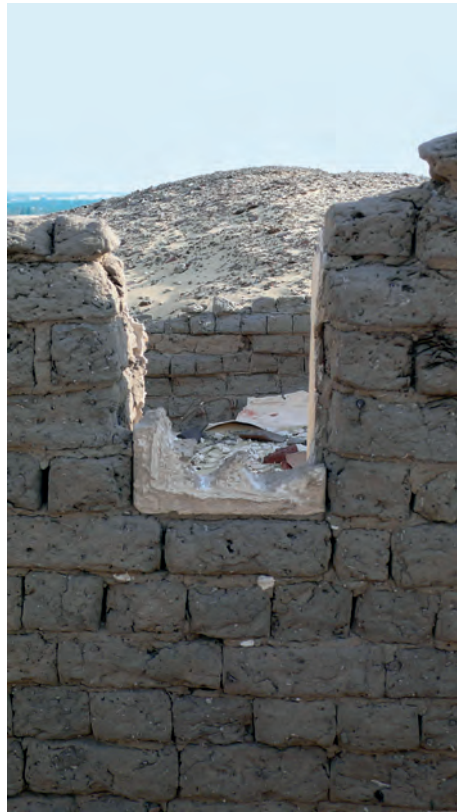
Abb. 16: GB 201.1.2, Außenansicht des Fensters von Norden mit unvollständig erhaltenem Fenstergitter aus Kalkstein; 2008
