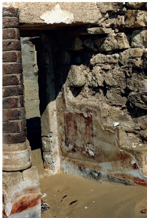
Abb. 12: Türbereich von Südosten; 1988
