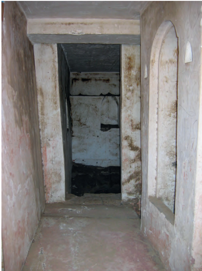
Abb. 20: GB 11, Obergeschoss, Eingangsbereich; 2007
