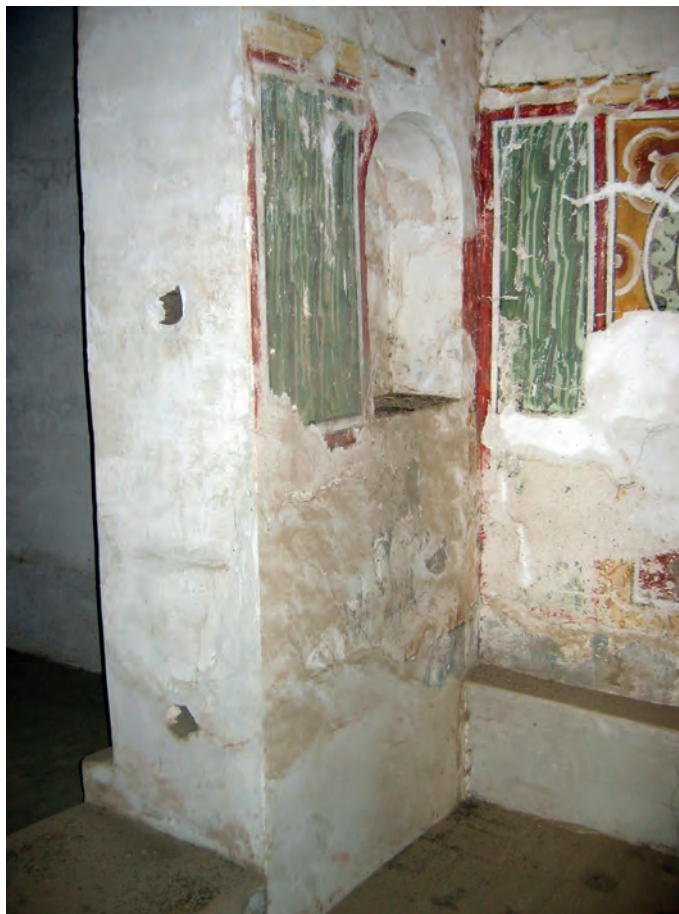
Abb. 16: GB 12, Obergeschoss, 1. Raum, westliche Südwand; 2006
