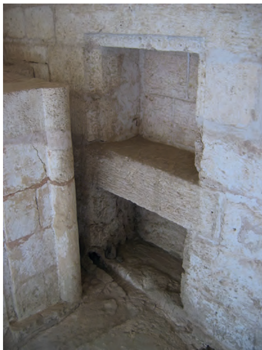
Abb. 16: GB 15, Innenraum, Westseite mit zwei übereinanderliegenden Nischen; 2007
