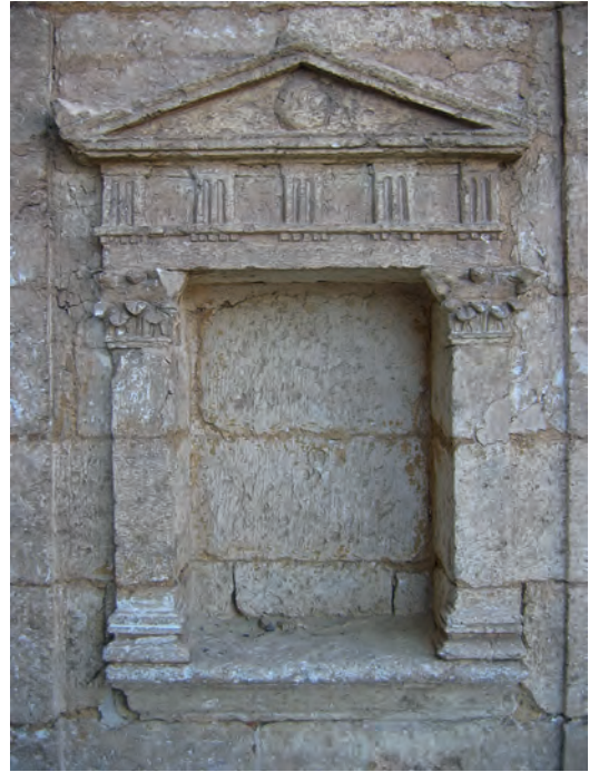
Abb. 9: GB 15, östliche Fassadennische; 2007
