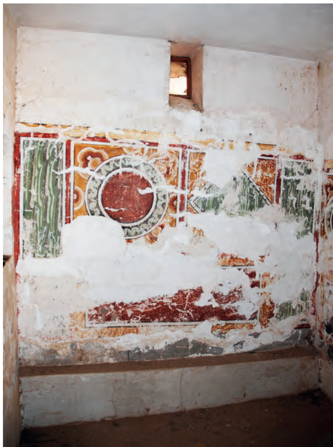
Abb. 15: GB 12, Obergeschoss, 1. Raum, Westwand; 2008
