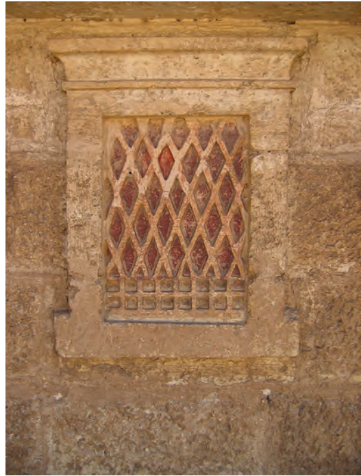
Abb. 7: Fassade, mittleres Fenster; 2006
