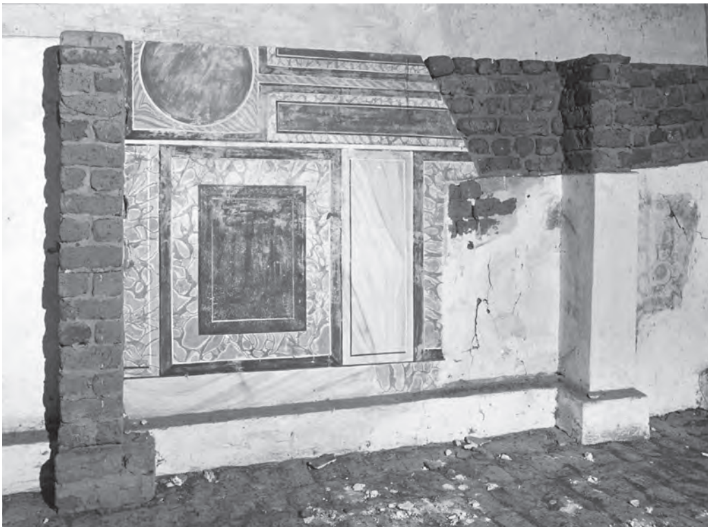
Abb. 46: GB 16, Obergeschoss, zweiter Raum, Südwand; 1973
