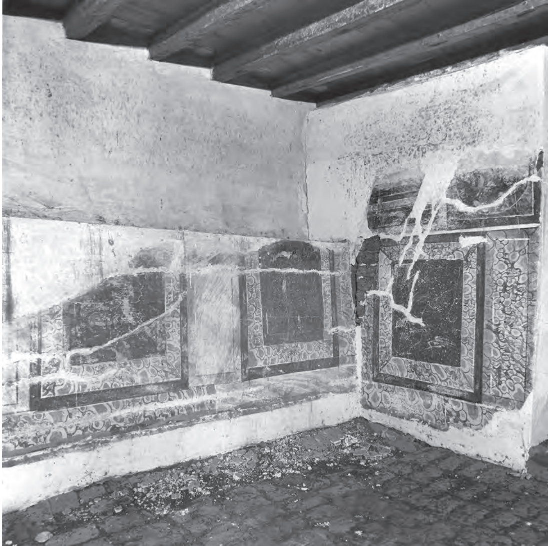
Abb. 39: GB 16, Obergeschoss, zweiter Raum, West- und westliche Nordwand; 1973
