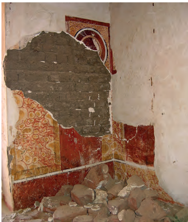
Abb. 33: GB 16, Obergeschoss, erster Raum, Nordostwand; 2005
