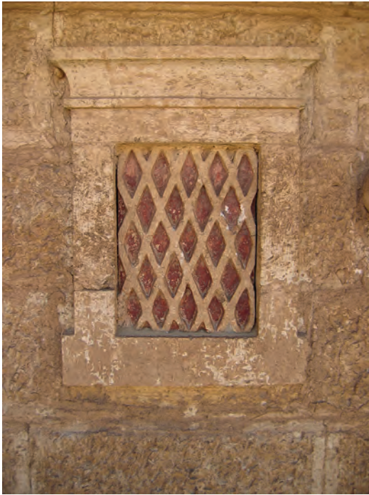
Abb. 6: Fassade, östliches Fenster; 2006
