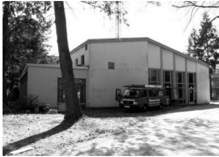
Abb. 41: Casino-Gebäude, Josef-Kammhuber-Kaserne, vor dem Umbau
