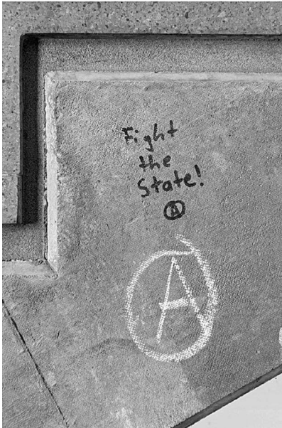
Abb. 8: UHG, Treppenturm BLC, Ebene 4.
