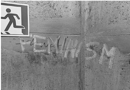
Abb. 10: UHG, Treppenturm D, Ebene 2.
