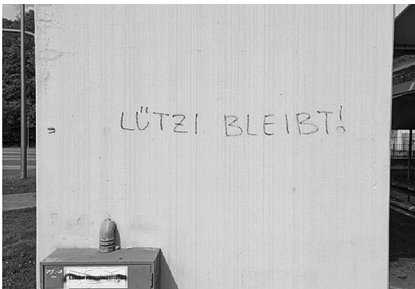
Abb. 11: Nordwestliches Treppenhaus von Parkhaus 3 (Außenwand).
