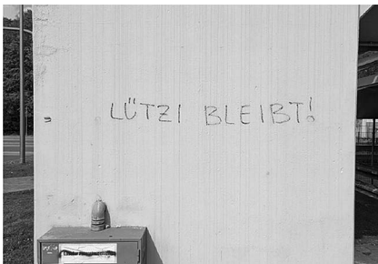
Abb. 11: Nordwestliches Treppenhaus von Parkhaus 3 (Außenwand).
