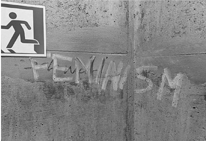
Abb. 10: UHG, Treppenturm D, Ebene 2.
