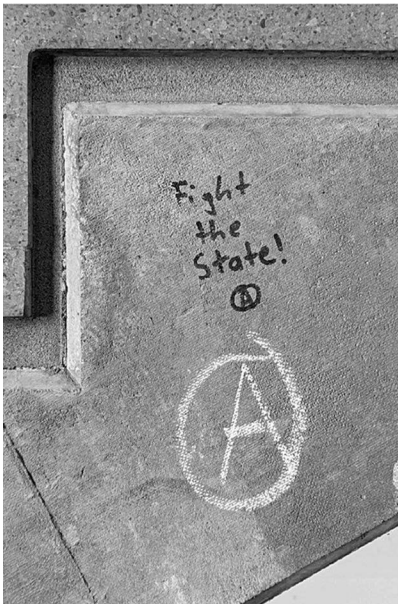
Abb. 8: UHG, Treppenturm BLC, Ebene 4.
