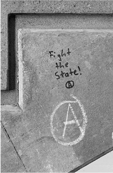
Abb. 8: UHG, Treppenturm BLC, Ebene 4.
