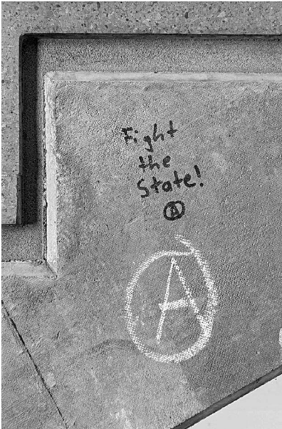
Abb. 8: UHG, Treppenturm BLC, Ebene 4.
