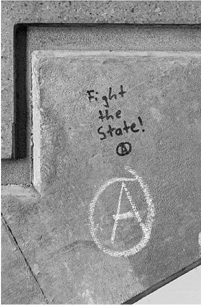
Abb. 8: UHG, Treppenturm BLC, Ebene 4.
