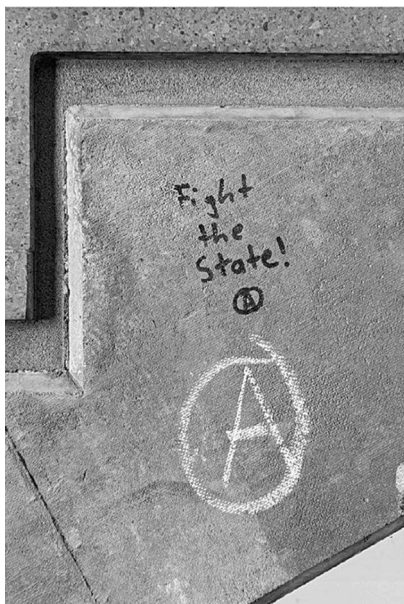
Abb. 8: UHG, Treppenturm BLC, Ebene 4.
