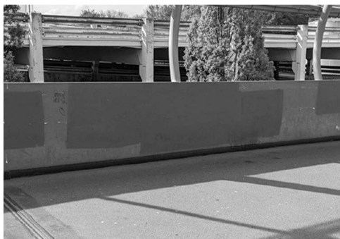
Abb. 2: Brückengeländer mit Flächen neuer Farbe, die u.a. „Jin, Jiyan, Azadi“-Graffitis aus dem vorangegangenen Semester überdecken.
