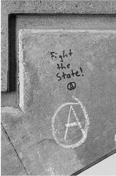
Abb. 8: UHG, Treppenturm BLC, Ebene 4.
