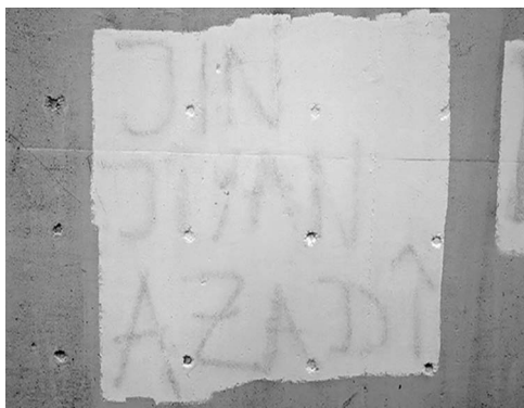
Abb. 3: Unter der Farbe erkennbares Graffiti an der Rampe neben dem Haupteingang des UHG.
