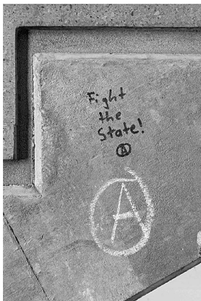
Abb. 8: UHG, Treppenturm BLC, Ebene 4.
