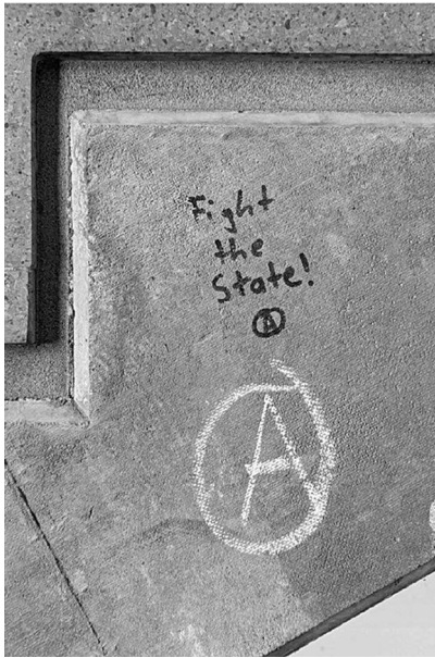
Abb. 8: UHG, Treppenturm BLC, Ebene 4.
