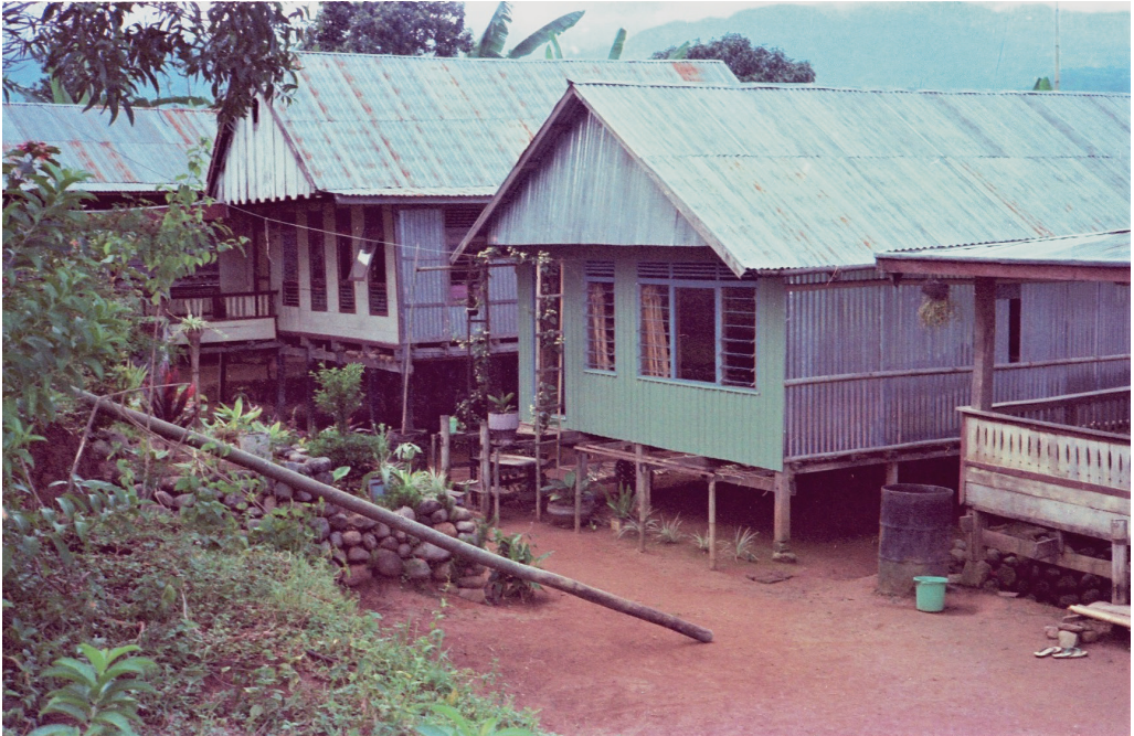
Abb. 2 Unsere erste Wohnung in Bontolowe, 1984. Fast alle Häuser dieser Art sind heute durch Ziegelbauten ersetzt. (Foto: Martin Rössler)
